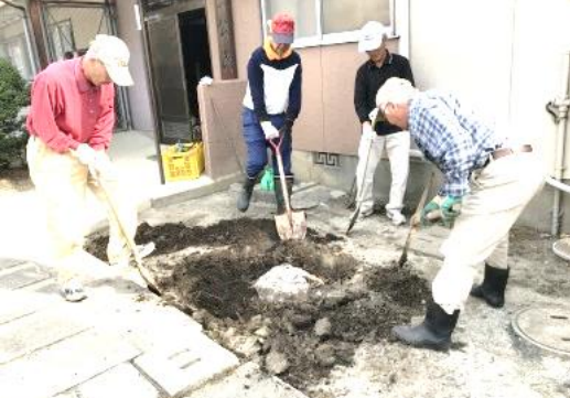
有志による工事
